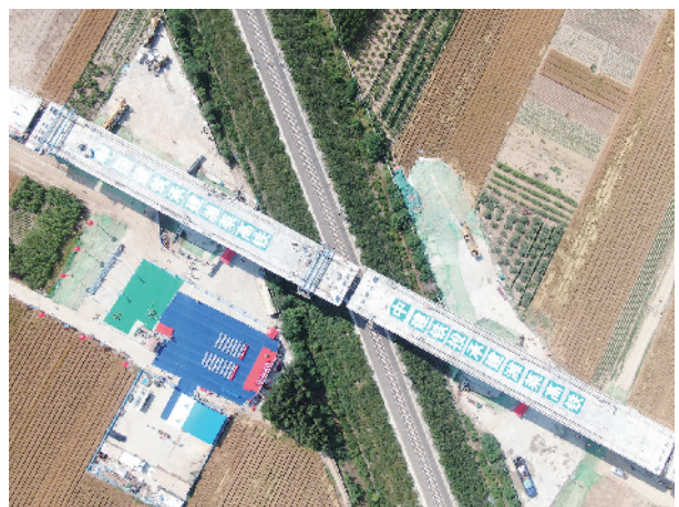
■潍莱高铁跨海青铁路转体桥梁合龙后的状态。傅学军 摄
